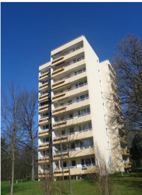
Außenansicht von Südosten
