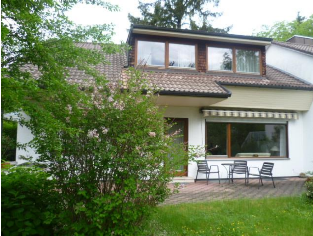
Hausansicht von Süden
