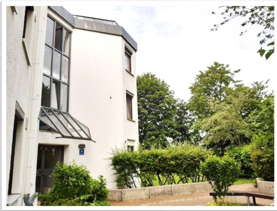
Hausansicht von Nordosten
