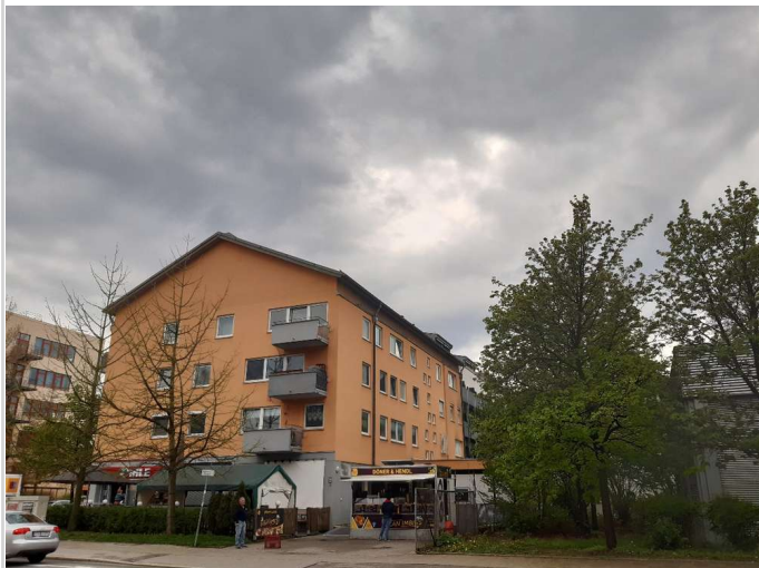
Hausansicht von Nordosten
