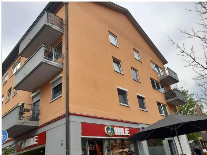
Hausansicht von Südosten
