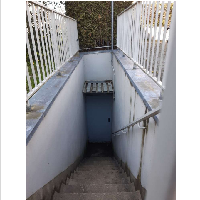
Treppenabgang zur Tiefgarage
