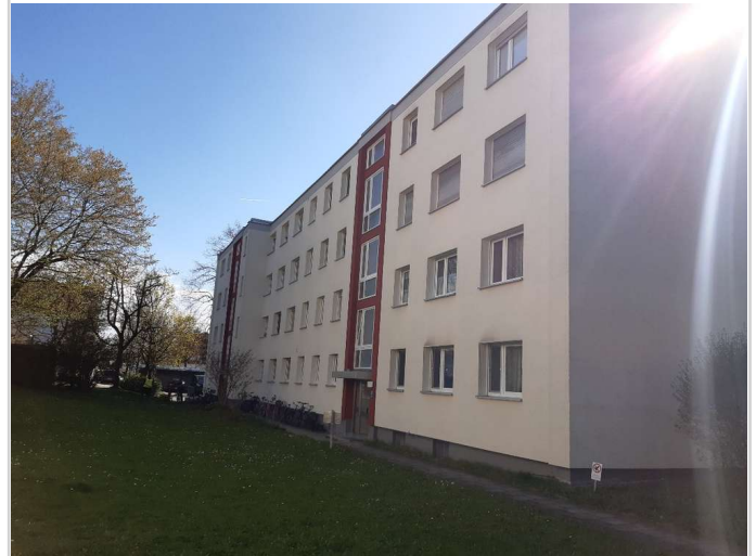
Hausansicht von Nordosten
